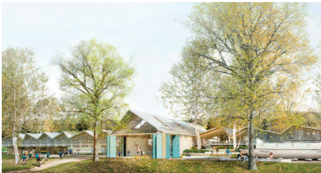
Der Um- und Neubau des Seesport- und Erlebnispädagogischen Zentrums erfolgt in filigraner Holzbauweise. Zwei Flügel werden an das Herz der Anlage, das Bootshaus, angebaut, um mehr Übernachtungen anbieten zu können. Visualisierung: Ludloff Ludloff Architekten
