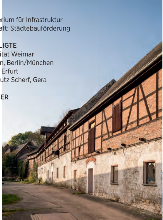
Scheunenzeile der alten Gutsanlage in Dornburg
