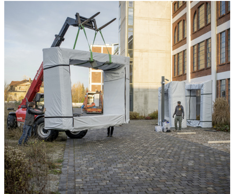
Aufbau des ›Timber Prototypen‹ in Apolda
