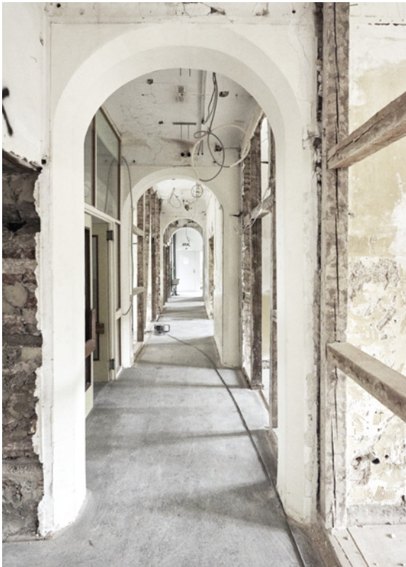
Die IBA Parkstad baut ein ehemaliges Kloster in eine Pflegeeinrichtung um.
