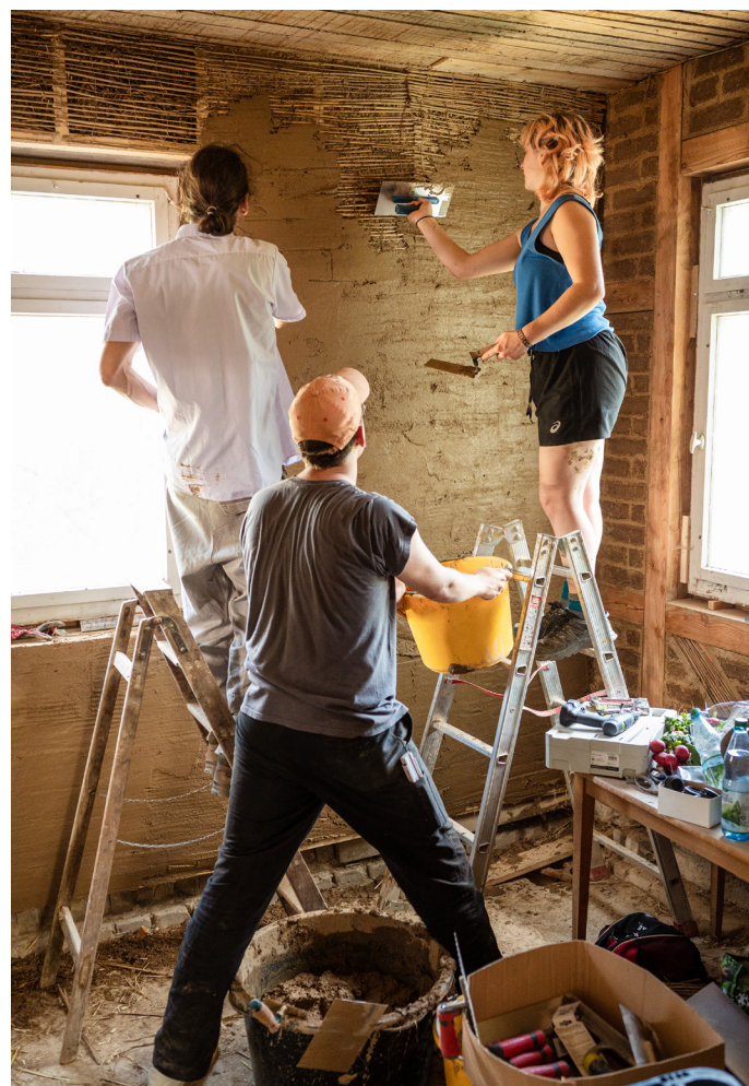
Bauschule beim Sommerfrische Haus Bräutigam im Schwarzatal, Foto: Thomas Müller
