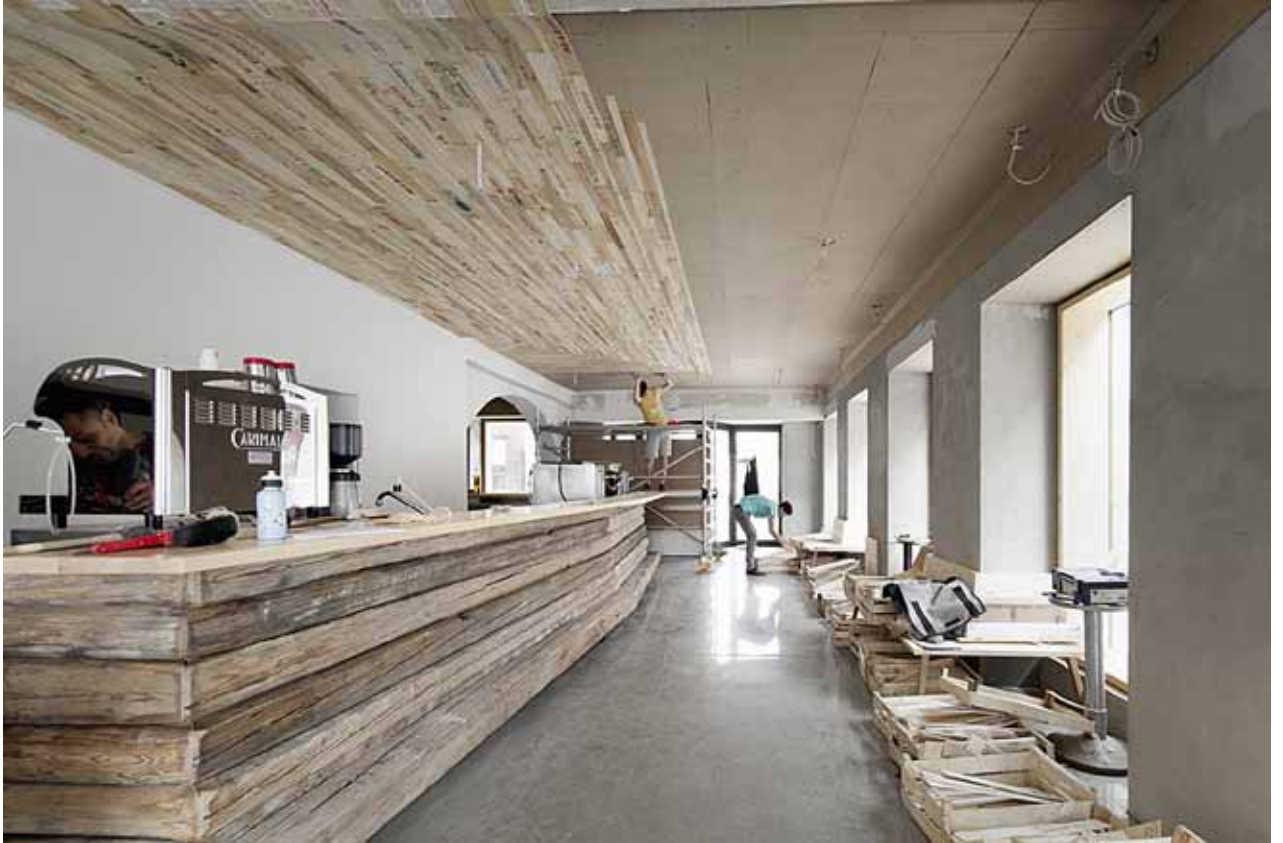
Ein Detail von VinziRast-mittendrin: Müll wird zur Wandverkleidung, © Kurt Kuball
