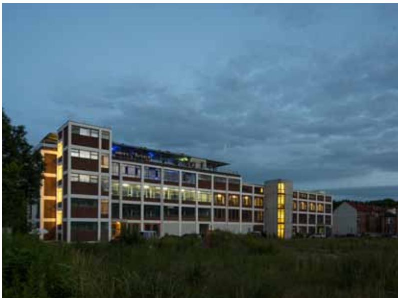
Der Eiermannbau in Nutzung, zumindest an zwei Tagen im Juni 2016.
